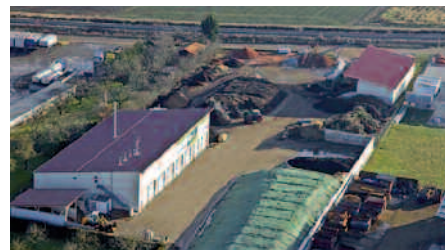
Das Boxenverfahren der Biogas-Anlagenbau Langenau entstand aus einem Kompostbetrieb. Foto: BAL
